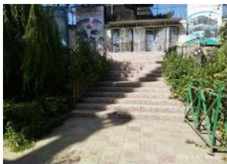
شکل ۶: ارتفاع نامناسب زینه در پارک کارته مأمورین (راست) نبود رمپ کنار زینه (چپ) پارک شهر (نویسنده)
